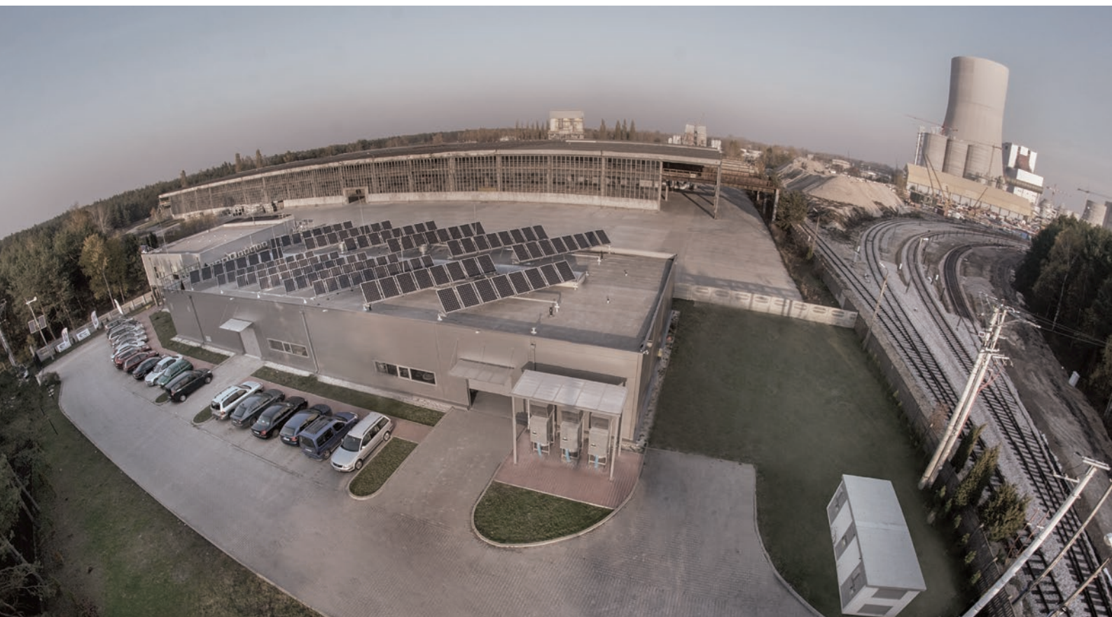
Biura oraz zaplecze produkcyjne firmy ENAP w sąsiedztwie Elektrowni Koźienice
