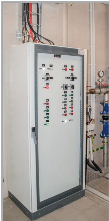
Rozdzielnica sterowania automatyką pomp, Metro Warszawskie
