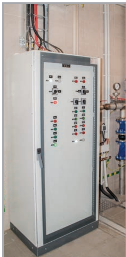
Rozdzielnica sterowania automatyką pomp, Metro Warszawskie
