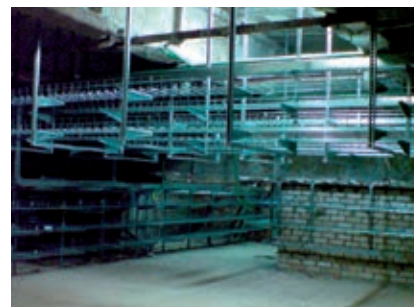
System koryt siatkowych montowanych w kablowni
